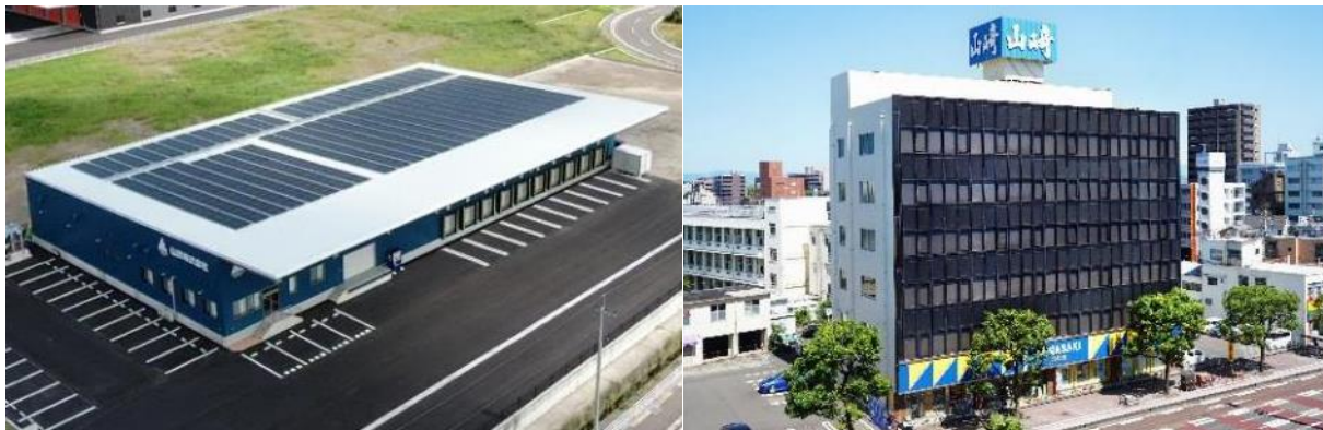
再エネ電力の供給拠点となる山崎都城営業所（左）と需要施設である山崎本社（右）
